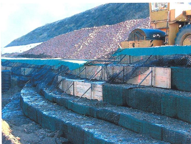
Geoműanyag alkalmazása egy töltésepítésnél
