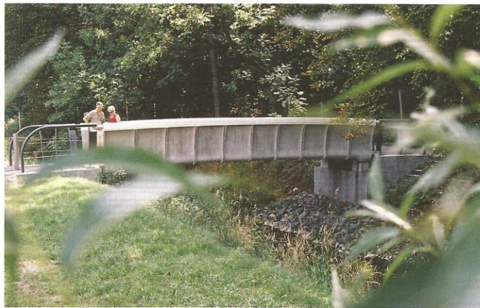
» 4. ábra. Textilbeton szerkezetű híd
